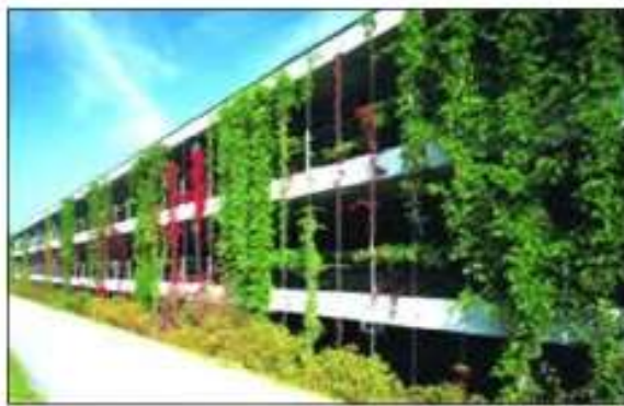
شکل ۲- دیوار سبز با شبکه فولادی ضد زنگ (۱۷)
